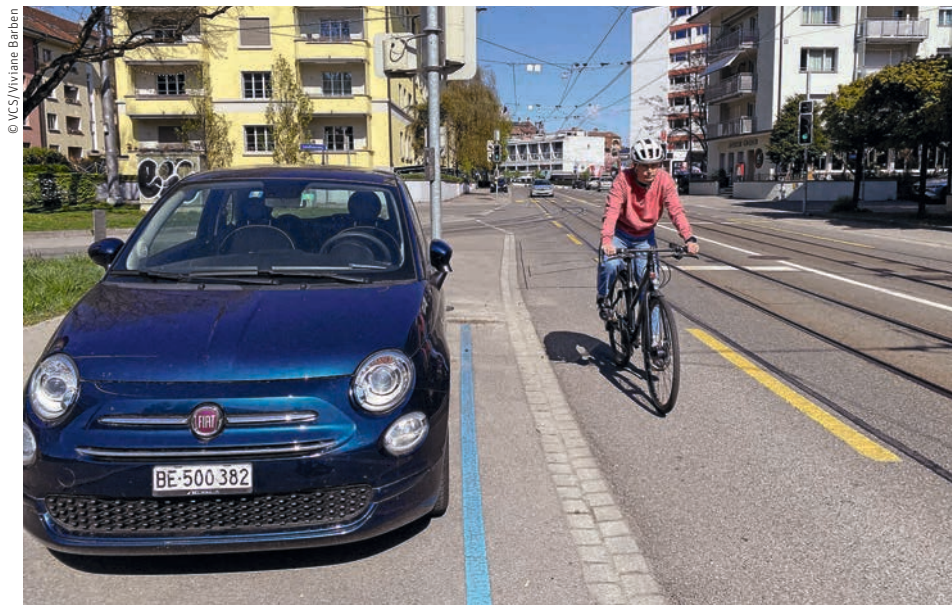
Die blaue Linie schafft einen zusätzlichen Abstand zwischen der Velofahrerin und dem parkierten Auto. Sollte die Fahrerin oder der Fahrer die Türen unverhofft öffnen, «verzeiht» die Infrastruktur diesen Fehler.
