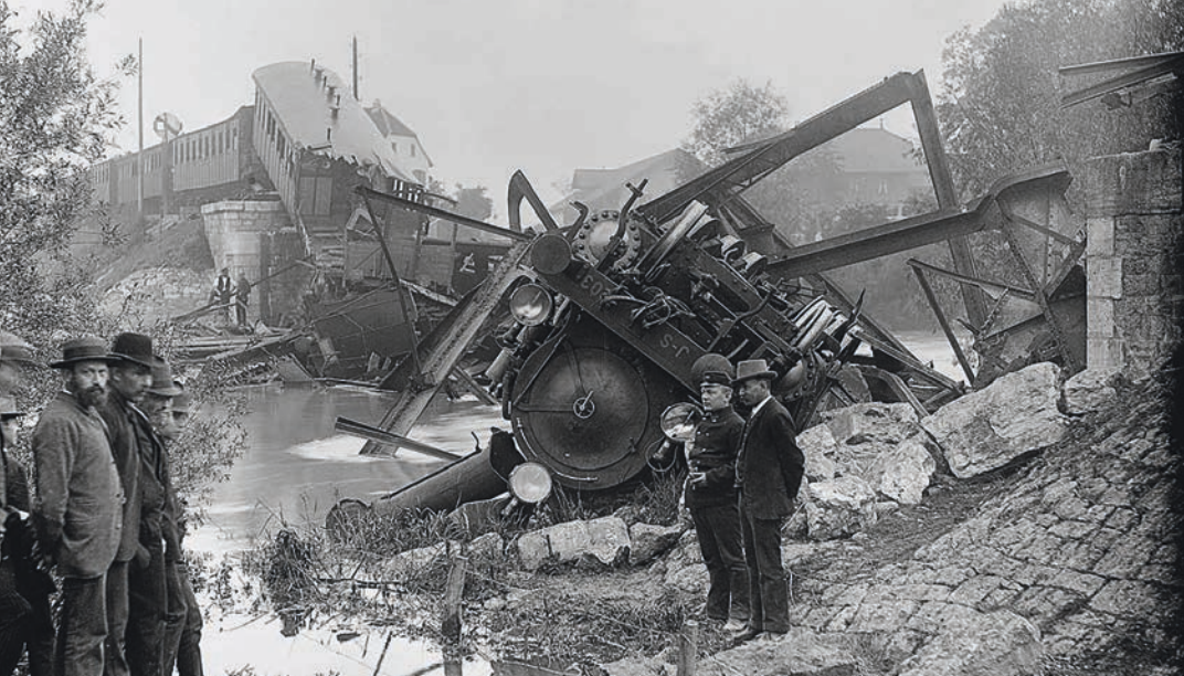
Das gesuchte Ereignis fand am 14. Juni 1891 statt. Im Kanton Basel-Landschaft brach eine Brücke unter der Last eines vollbesetzten Eisenbahnzuges ein.
